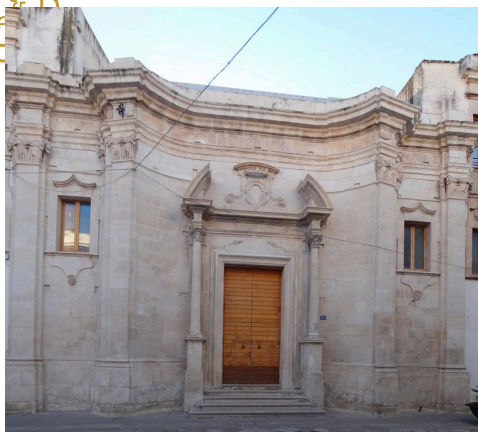
Auditorium Palazzo Celestini, Manfredonia. Restauro facciata lapidea.
